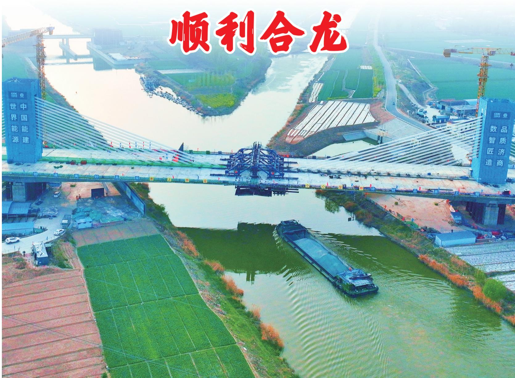
4月10日上午,济宁至商丘高速公路嘉祥至金乡段项目关键控制性工程——新万福河特大桥主跨顺利合龙。合龙的新万福河特大桥是济商高速全线关键控制性节点工程,为双塔单索面预应力斜拉桥,全长882米,主桥长395米,主跨长185米,桥面宽35.5米,主塔高32米,比预定工期提前了4个月完成合龙,标志着济商高速项目建设取得重大突破,为项目全线完工通车创造了有利条件。
