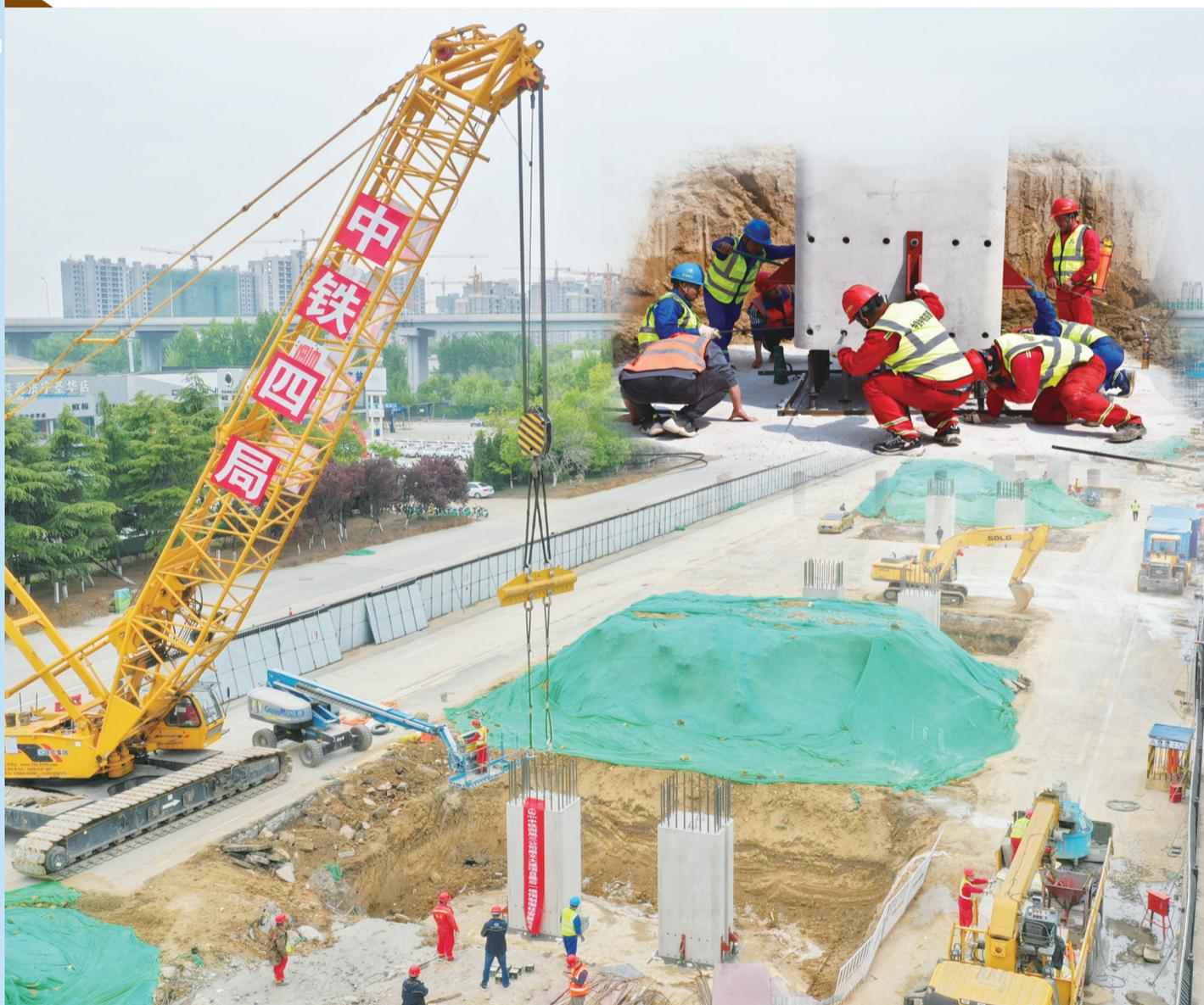
4月24日,崇文大道跨宁安大道项目最后一根预制墩柱安装完成,比原计划提前6天。目前,该项目桩基、承台、现浇墩柱、预制墩柱生产安装、预制盖梁生产已全部完成。计划4月27日完成箱梁生产,5月13日开始架设钢箱梁。(本报记者 刘菲)
