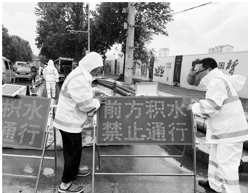
工作人员在积水路段设立警示牌
