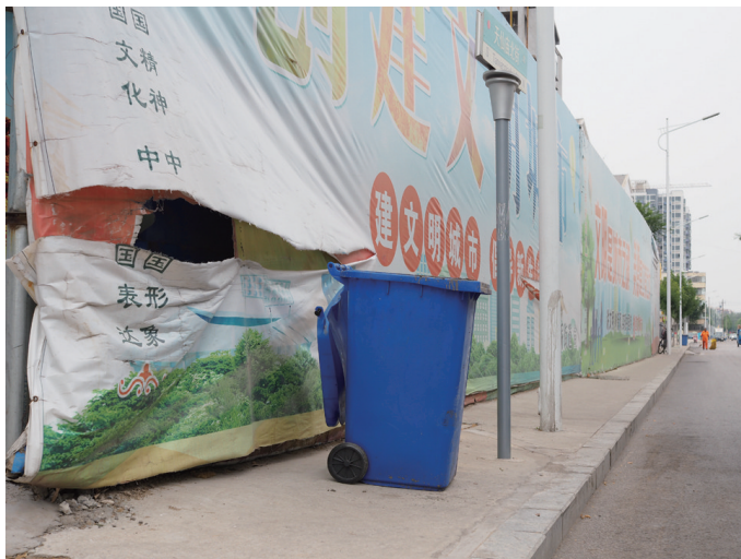
位于天仙庙北街南侧的创城公益宣传牌有较大程度破损,未及时更换。[20180602号]
