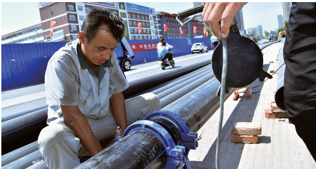
随着夏季用电高峰的临近,我市用电负荷持续快速攀升,为消除电网安全运行隐患,城区火炬路重新铺设地下电缆,为居民用电提供有力保障。图为工人正在铺设电缆管道。(记者 董绍进 摄)
