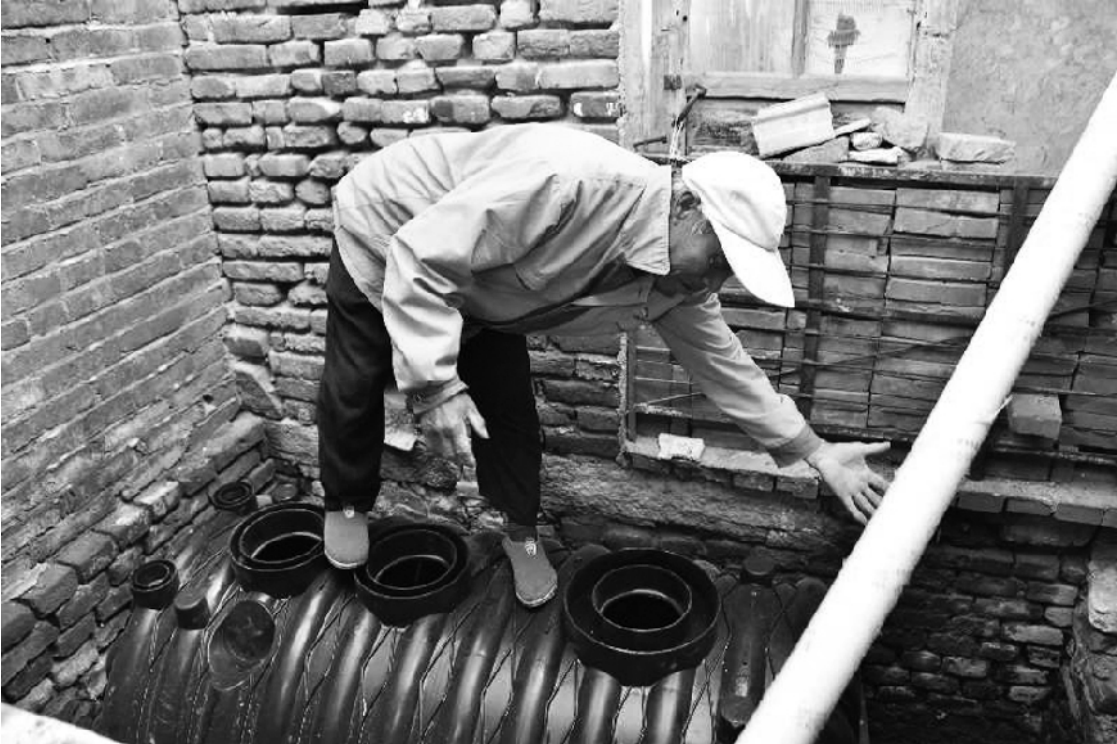
农村改厕施工中
