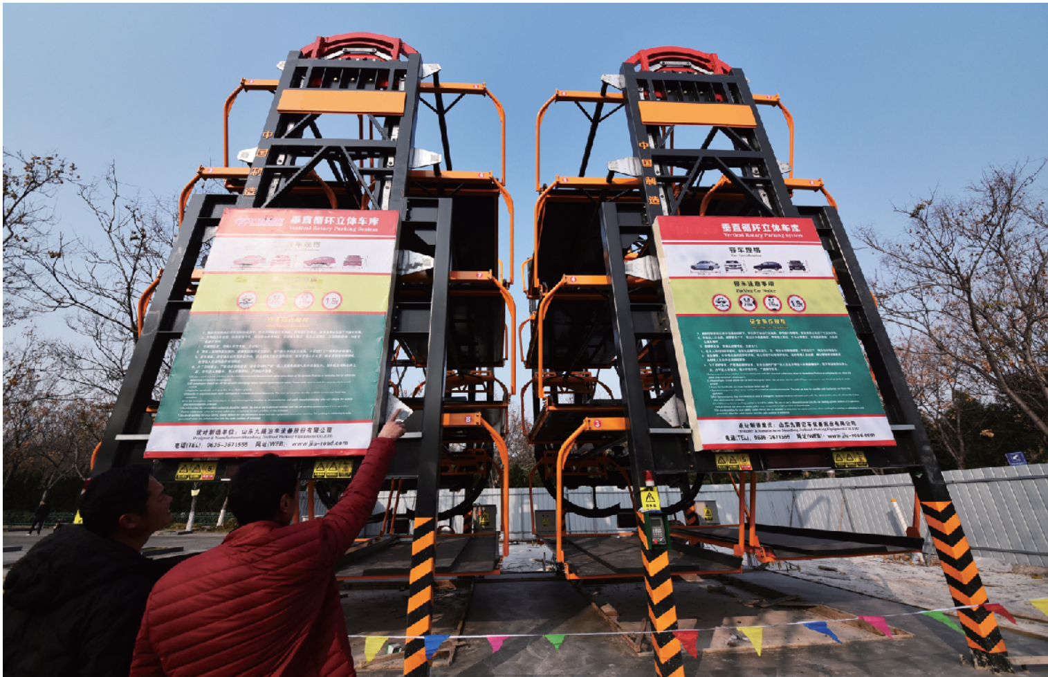
南池公园南侧公共停车场,工作人员正在调试垂直循环立体车库。据介绍,这种立体车库技术先进,建成后 2 个车位的位置可以停放 8 辆机动车,作为试点停车设施,预计近日进行试运用。(董绍进 摄影报道)
