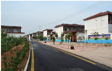
曲阜市夫子洞至周庄农村路，全长 1.2 公里，宽 7 米，三级公路，位于曲阜市尼山镇周庄村，途经尼山风景区，是该村连接省道 611 的重要道路。
