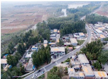
泗水县泗桃线农村路，是连接泗水县东南部山区的一条主要道路，道路通车后，山区实现了人便其行，货畅其流。
