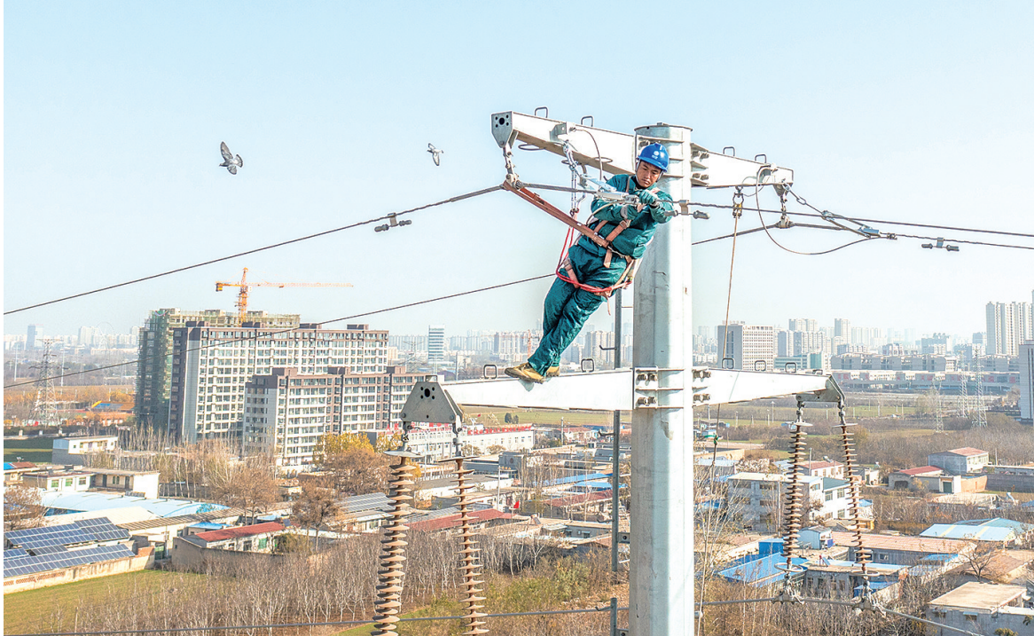
11月26日,随着最后一处跨越铁路的35千伏嘉益线备份导线安装完毕并顺利投运,国网嘉祥县供电公司县内“三跨”线路专项治理工作圆满收官。本次治理累计完成39处跨越铁路、高速公路、重要靠电通道的线路备份安装,全面实现县内“三跨”隐患动态清零,为区域电网安全稳定运行和居民生产生活用电筑牢坚实屏障。
