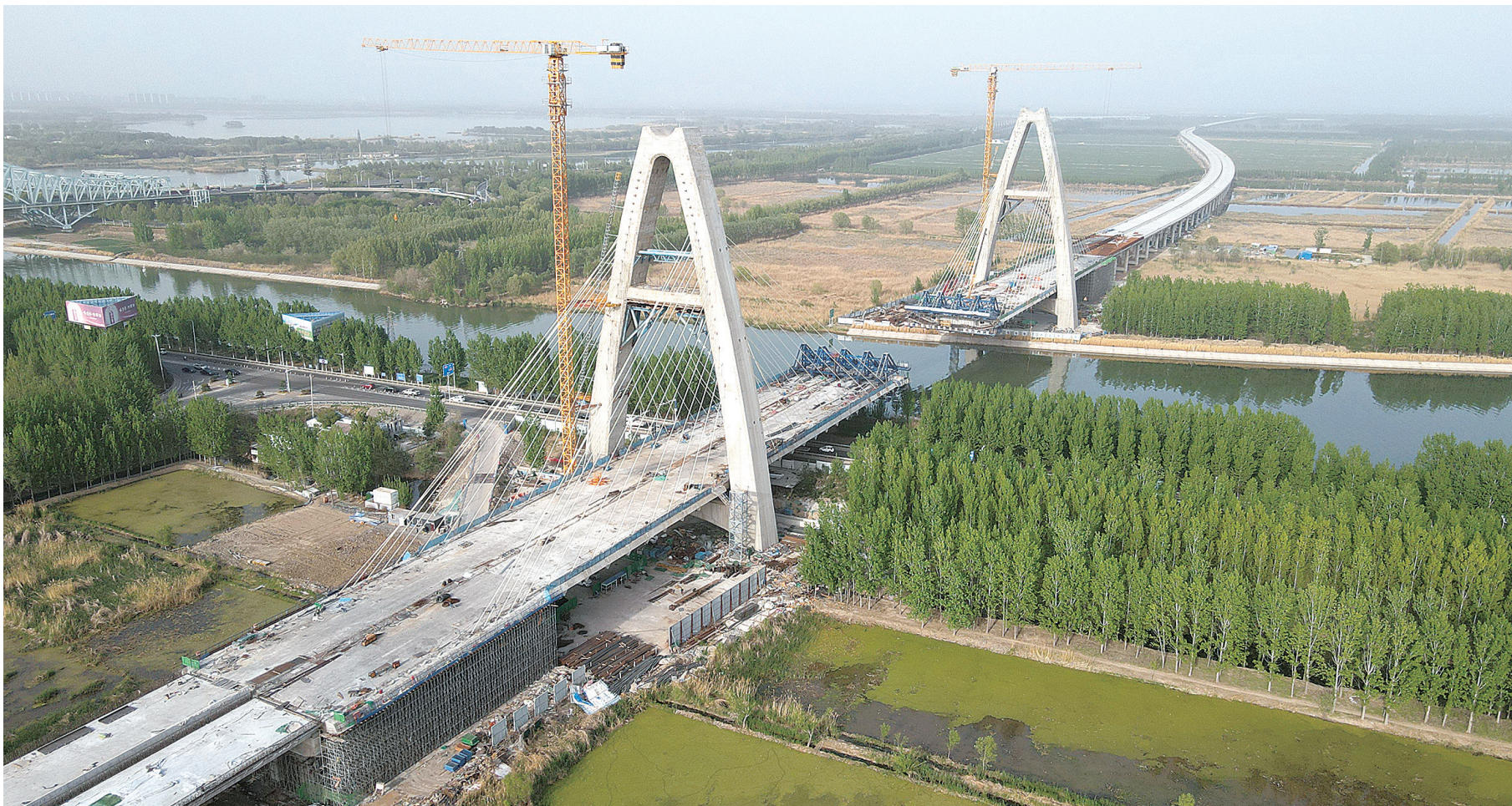
京杭运河特大桥
