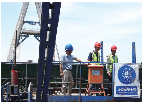
大桥施工安检
