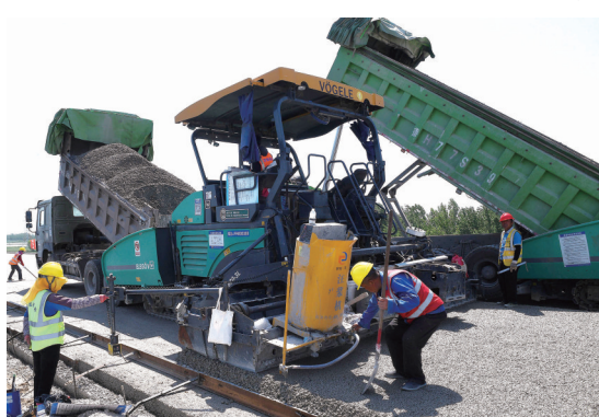
济邹高速路基摊铺
