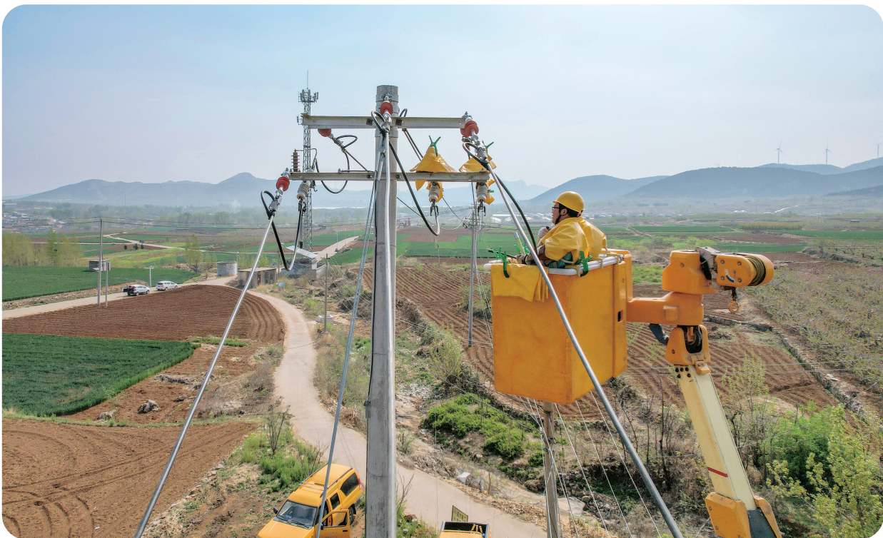
春耕春灌正忙时。为全力保障春耕春灌用电，国网济宁供电公司开通春灌办电绿色通道，组织服务人员开展线路特巡视。图为4月10日，国网泗水县供电公司 在10 千伏都线大峪口 支线开展带电消缺工作，保障沿线村民春灌用电可靠。
