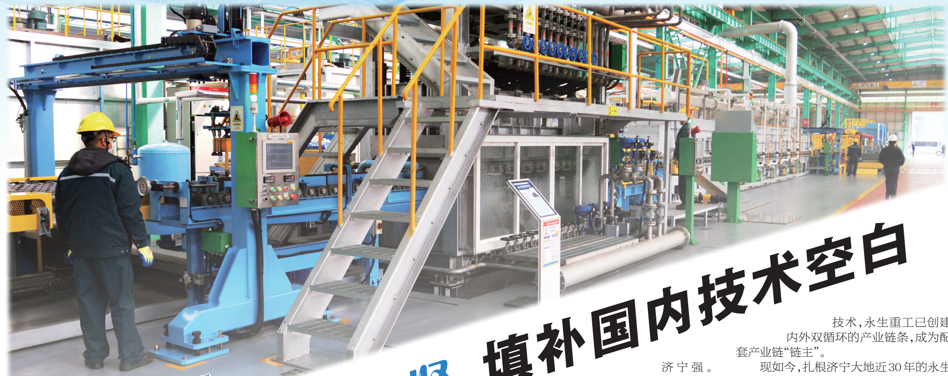
永生重工生产车间 ■记者 刘建新 摄
