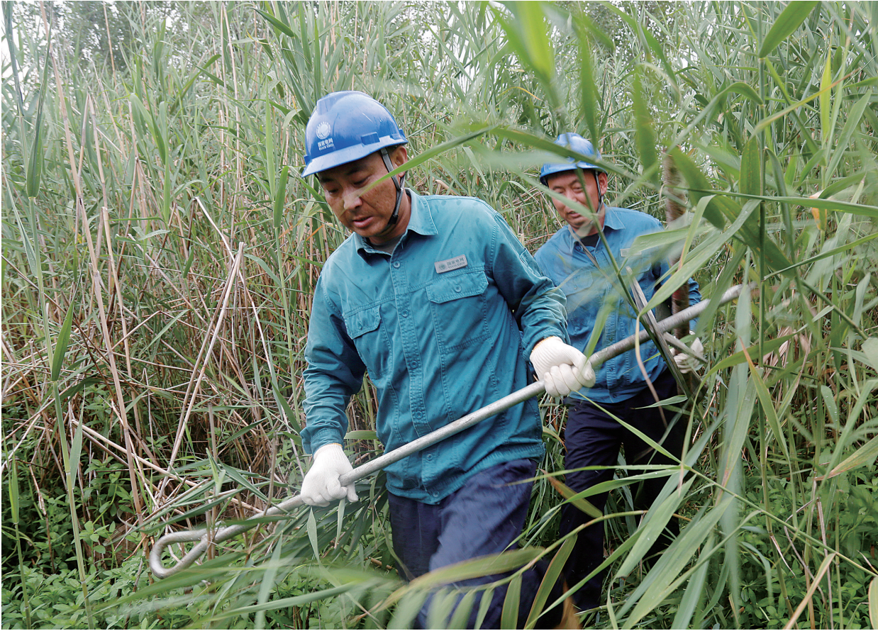
近期的强降雨造成南四湖水位上涨，给湖区内电网设施带来严峻考验。为应对湖区低洼状况，做好河道近区及泄洪区电网设备防汛保供，国网济宁供电公司组织人员开展湖区线路设备特巡特护，及时消除供电隐患，守护湖区万家灯火。图为供电员工对微山湖中倾斜的 10 千伏利民线 19 号杆更换拉线。
