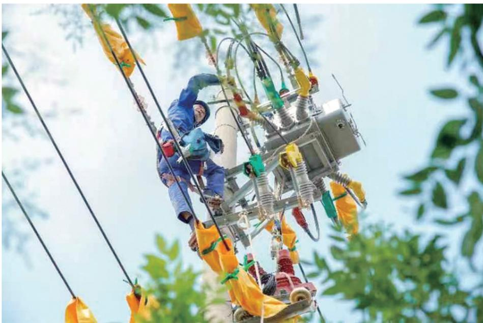
7月5日至8日，济宁连续遭遇暴雨、大风强对流恶劣天气，国网济宁供电公司第一时间启动应急响应，迅速组织抢修人员开展电网抢修消缺和线路设备特巡，保障电力可靠供应。图为供电员工对泗水圣水峪10千伏库厂线77号杆开展故障抢修。
