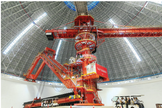
山东能源泰安港新能源数字陆港产业园项目(东平)。
