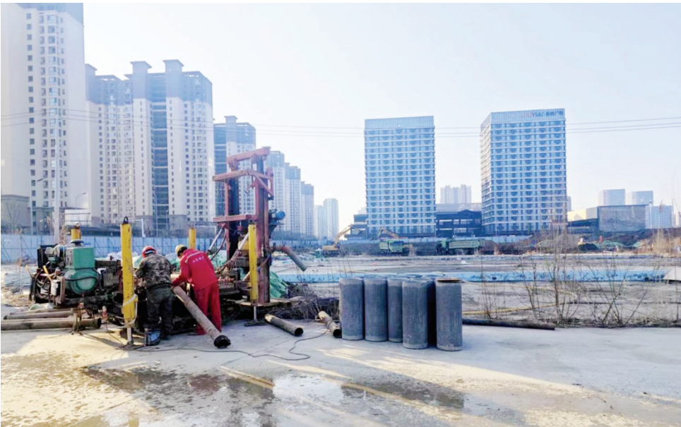
太白湖新区渔皇小学,施工人员正在检查桩基设备,开始进行桩基施工。
