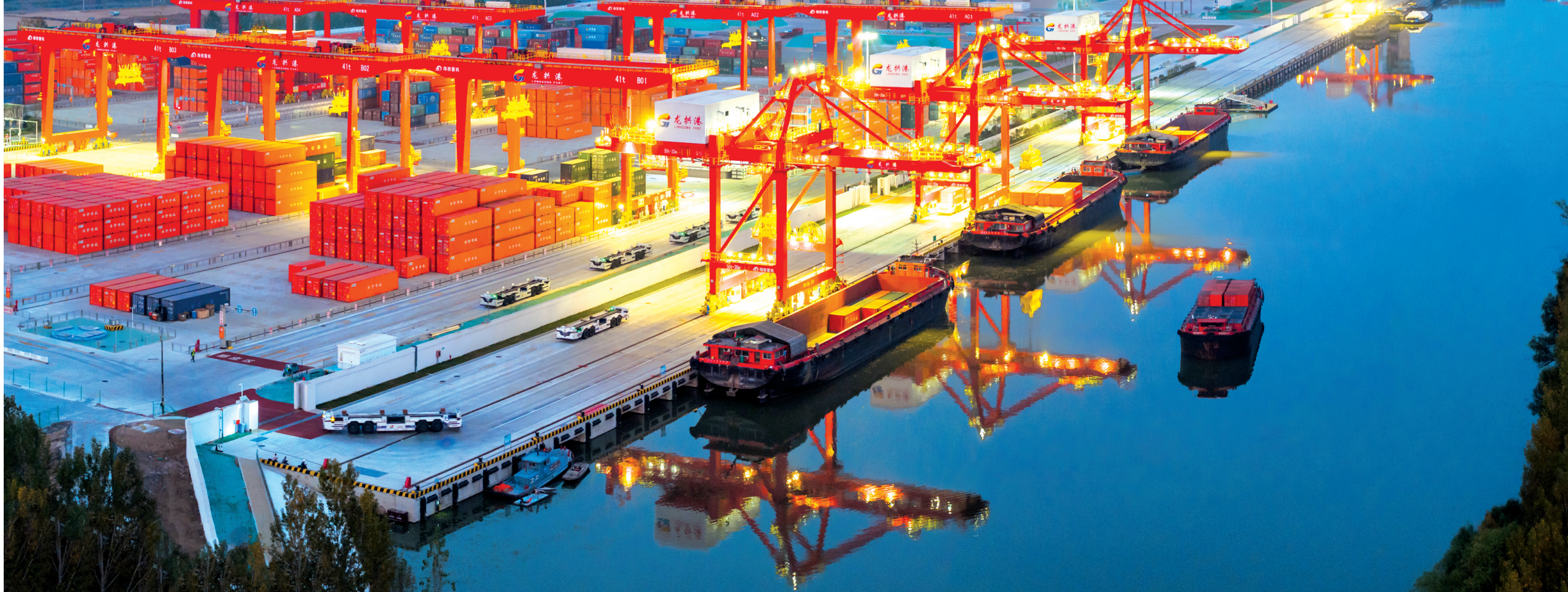
龙拱港智能化泊位、海关监管场所等建设项目提前竣工
