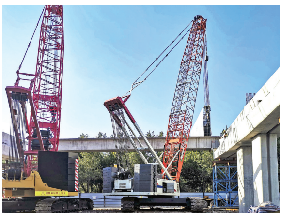
首片箱梁安装
