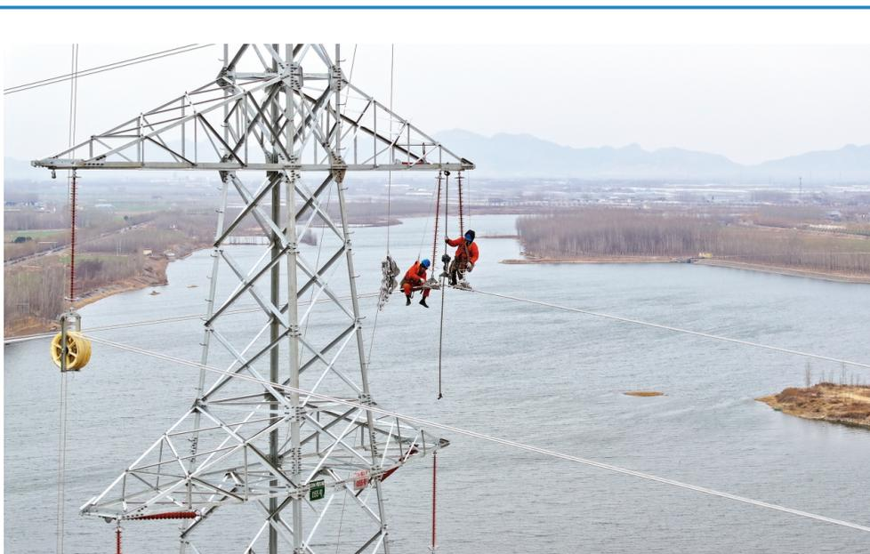
12月10日，国网济宁供电公司施工人员进行新建220kV 儒红线跨越泗河线路部分的附件安装工作，工作人员克服低温寒潮等带来的不利影响，经过4个小时，顺利完成作业。
