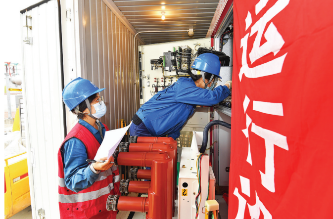
曲阜市供电公司工作人员在35千伏书院变电站开展间隔预试、保护全检工作,进一步提升设备安全运行水平,确保电网供电安全可靠。
