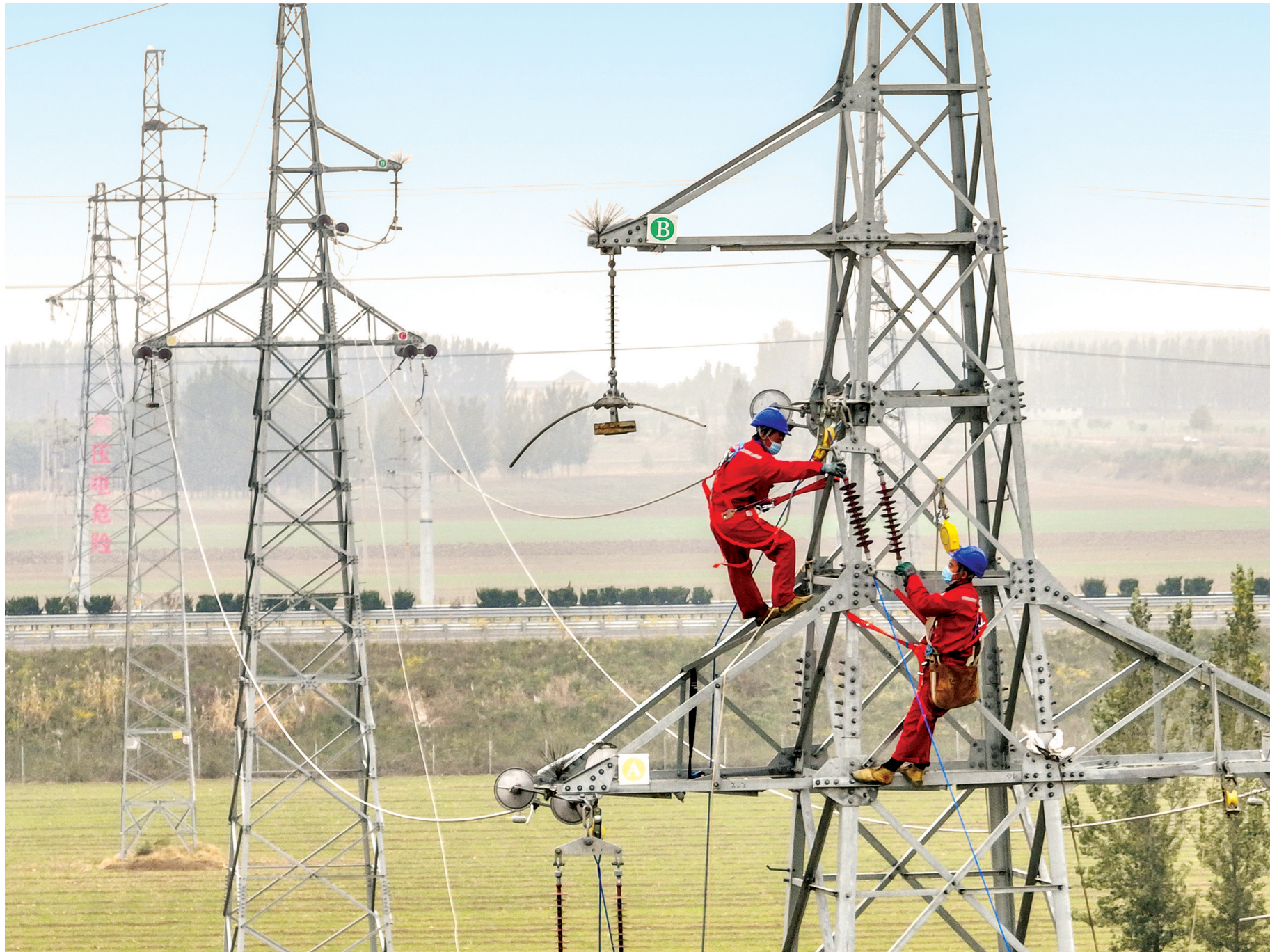
汶上县供电公司35千伏泉杨线军屯支线进行改造,消除老旧线路隐患。
