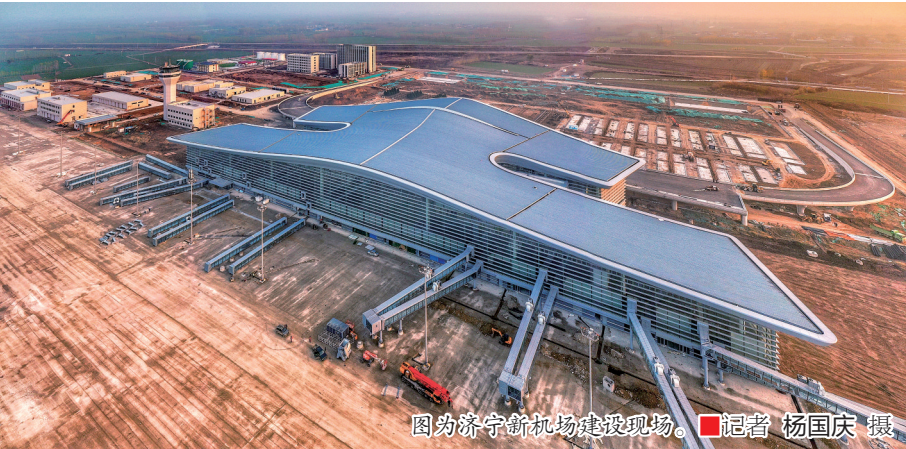
图为济宁新机场建设现场。■记者 杨国庆 摄
