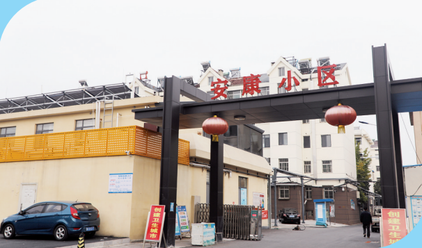
安康小区老旧小区改造
