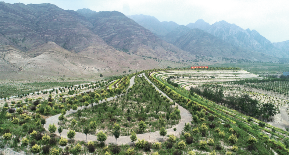
这是位于宁夏吴忠市平罗县崇岗镇的贺兰山东麓黄坛子生态修复治理工程(2022年8月2日摄)。
