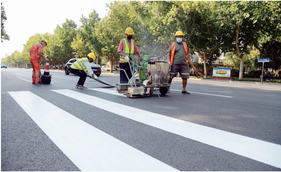
吴泰南路、常青路是市区的重要交通道路,此次改造项目东起洸府河、西至济安桥路,全长6.6公里,红线宽度40米。经过建设者们日夜奋战,现主路施工全部完工,全线放开通行,已进入标线施划、绿化及附属工程施工阶段。图为工程技术人员正在吴泰南路进行标线施划。 ■记者 刘建新 摄
