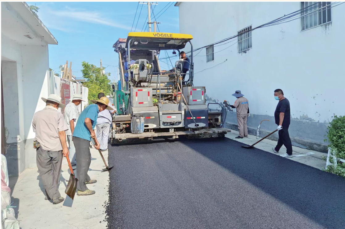
近日,任城区安居街道扎实开展创建工作,制定专项整治方案,确保各项创建工作落到实处。他们对各村墙面进行清理并重新粉刷,对破损公益广告重新制作,重新更换绿化带护栏,重新规划复新村内道路沿线停车位,辖区村村容村貌焕然一新。图为村庄道路施工现场。
