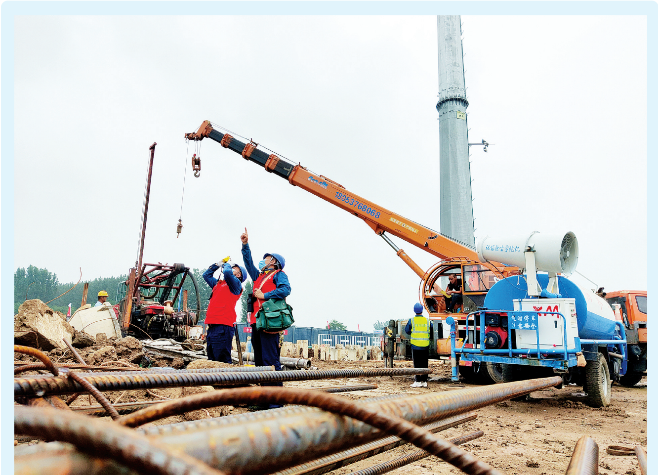
在高压线附近机械施工,有触电风险,威胁电网安全运行。国网济宁供电公司组织输电党员突击队队员在施工点安装电力安全警示标识牌,向施工人员讲解如何防范高压电触电风险,并协助施工人员划定安全施工范围,全程安全监管指导,确保施工安全,防范电网外力破坏,保障电网安全稳定运行。
