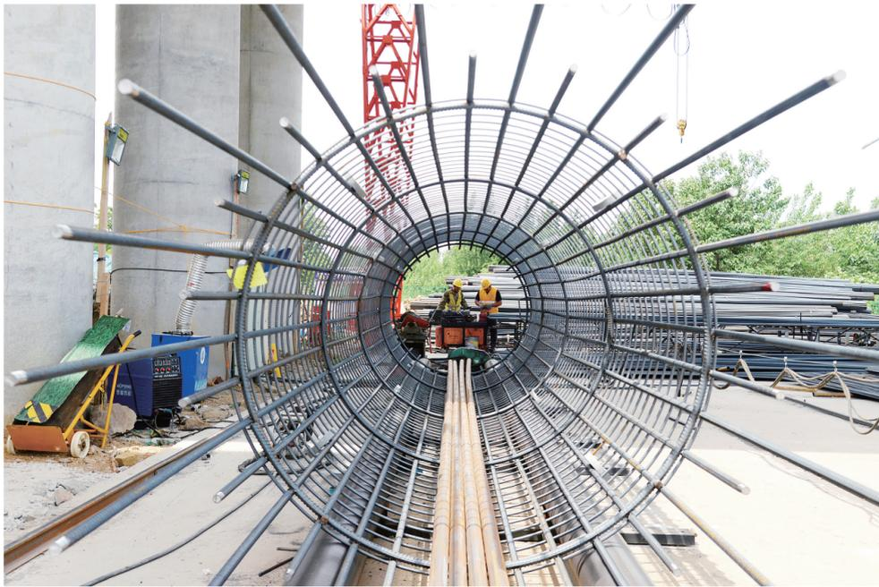
路网连民心,无言树丰碑。近年来,我市始终把把城市道路建设放在突出位置,持续加大基础设施投入,织就“快速网”、畅通“微循环”,进一步拉大城市框架,完善城市功能,着力构建便捷、高效、高品质城市综合交通体系,夯实高质量发展、赶超发展的基础。图为在海川路北延工程上跨新兖铁路立交桥项目施工现场工人们正在绑扎墩柱钢筋笼。 ■记者 刘建新 摄
