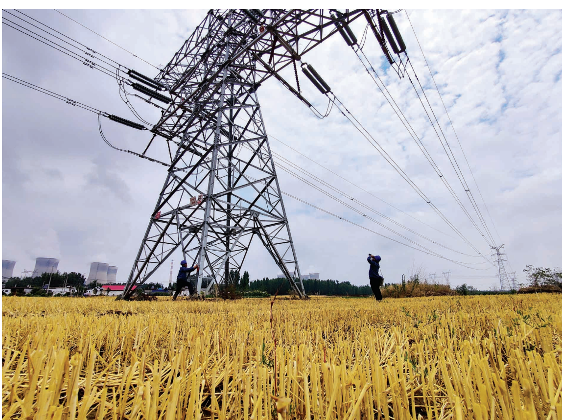
▲近日,我市出现强降雨天气。为防范恶劣天气对电网安全运行带来的不利影响,国网济宁供电公司组织员工开展线路设备特巡,及时消除缺陷隐患,确保电网安全度汛。图为供电员工在雨后对220千伏邵宿线开展特巡。 ■通讯员 李军 滕鹏飞 摄
