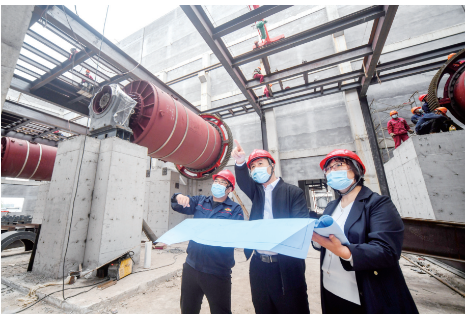
图为嘉祥县行政审批部门工作人员在山东世纪连泓新材料项目建设现场了解工程进度,帮助企业解决项目推进中遇到的困难。 ■记者 杨国庆 摄
