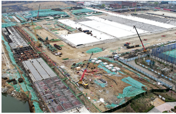
龙拱港扩建工程
