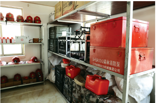
先进的消防设备
