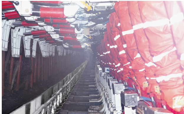
鲁泰控股集团在鹿洼煤矿建成全市地方煤矿首个智能化采煤工作面
