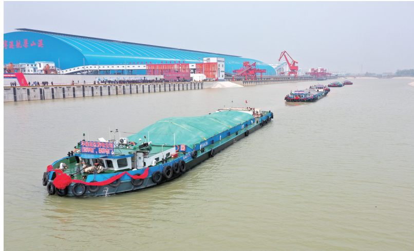
今年建成的梁山港被誉为我国最大“地上煤矿”。
