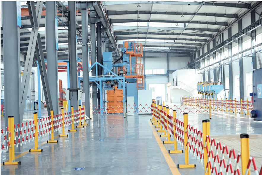
图为落陵盛源精密制造产业园项目。■记者 陈硕 摄
