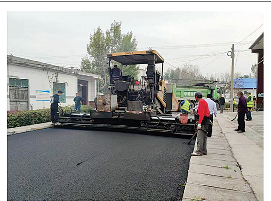
近期，太白湖新区石桥镇出动大型机械，对辖区镇村道路进行维修养护与提档升级，路面铺设柏油，进一步优化群众出行环境。此次道路提升工程涉及苏庄、陆桥等7个村庄，及栗河村泗河大堤路段，总计约9.2公里。
