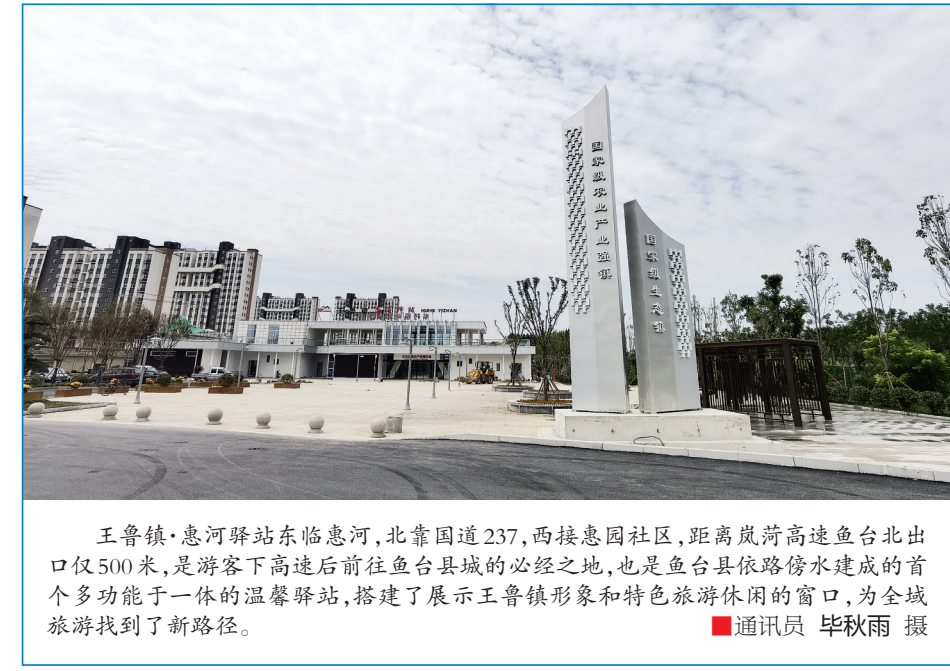
王鲁镇·惠河驿站东临惠河,北靠国道237,西接惠园社区,距离岚漪高速鱼台北出口仅500米,是游客下高速后前往鱼台县城的必经之地,也是鱼台县依路傍水建成的首个多功能于一体的温馨驿站,搭建了展示王鲁镇形象和特色旅游休闲的窗口,为全域旅游找到了新路径。 ■通讯员 毕秋雨 摄
