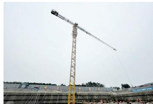
本报济宁讯 8月11日,济宁金融中心项目1#塔吊安装完成并投入使用。该塔吊选用T600-25U型,最大安装高度达221米,最大起重力矩达6000千牛米,现为济宁市房建领域应用的最大的吊装设备。该塔吊安装具有超尺寸大、重量大、安装场地要求高等特点,属于国家规定的超危大工程。在1号塔吊安装前,项目召开多轮专家论证会,编制专项施工方案,明确责任分工,做好现场各项准备,仅安装耗时7天完成。
