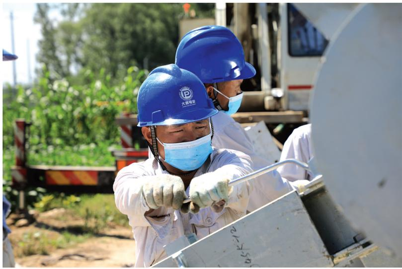
7月26日,在梁山县马集镇穆屯村西,梁山县供电公司施工人员顶着烈日对新建10千伏马管11线组立钢管杆,为马集镇经济发展提供充足的电力保障。该项工程,共组立电杆76基,其中钢管杆9基,水泥电杆67基,新建架空绝缘线路10.1千米,敷设电缆线路2.2千米,安装柱上开关5台、跌落式熔断器6组。线路竣工投运后,将进一步优化电网结构,改善区域供电质量。
