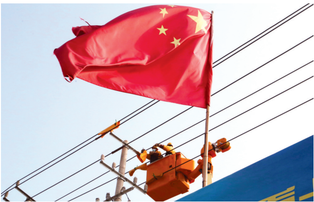
3月4日,国网金乡县供电公司员工在10千伏金兴线38号杆开展带电作业,为金乡跃航汽车维修有限公司配电工程带电T接送电,确保企业如期投产。 ■通讯员 侯成旭 摄
