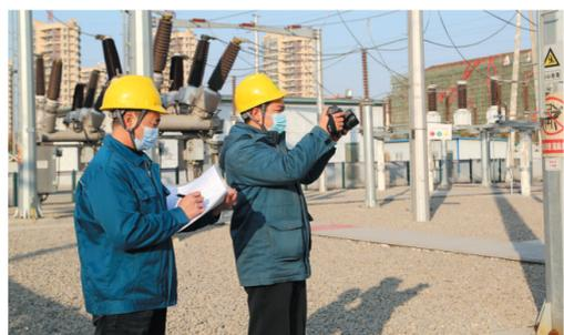
近日,金乡供电公司针对冬季气温低、用电负荷大的特点,组织人员对输电设备的红外测温工作,准确掌握线路在低温、重载情况下的运行状况,确保电网安全度冬。 通讯员 侯成旭
