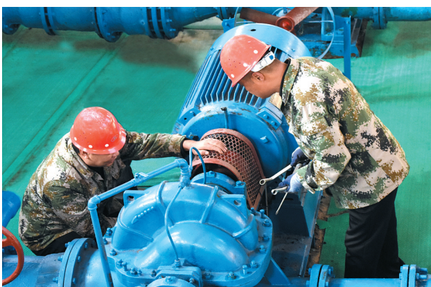
日前,邹城公用水务有限公司积极应对极寒天气,迅速组织200余人对全市供水设施进行防冻巡查和抢修,及时解决各类冻堵问题。同时,成立了100余人应急送水队伍,将1200余桶纯净水送到用户家中,让居民在第一时间喝上了“放心水”。 ■通讯员 高广秀 摄
