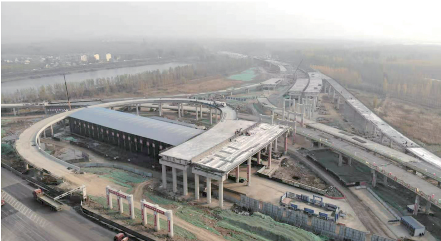
图为南二环互通立交建设现场。
