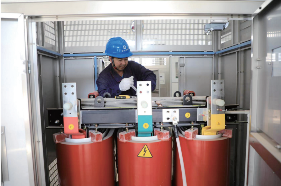
供电公司技术人员为企业调试输电线路。■通讯员 吴敬华 摄
