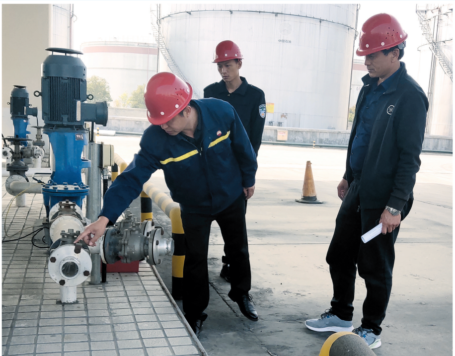
安居街道安监执法人员深入企业，对企业安全生产主体责任落实、工人安全操作、特种作业及安全档案管理等情况进行检查，督促企业落实安全生产主体责任，将安全生产专项整治三年行动贯彻落实到安全生产管理中，开展好员工安全知识教育培训，切实抓好隐患排查治理，确保生产安全。
