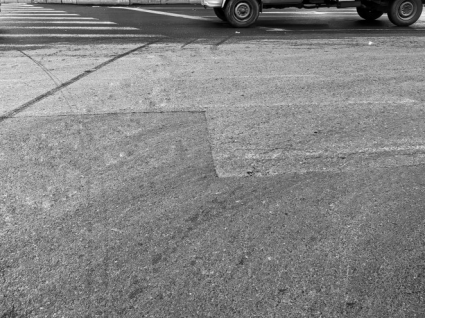
近日,记者对曝光的20200830号问题进行回访时看到,南池路与玄帝庙街十字路口处破损的路面已修复完成。 ■记者 陈硕 摄 20201012号
