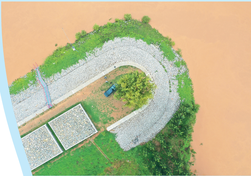
程那里险工(梁山黄河河务局供图)
