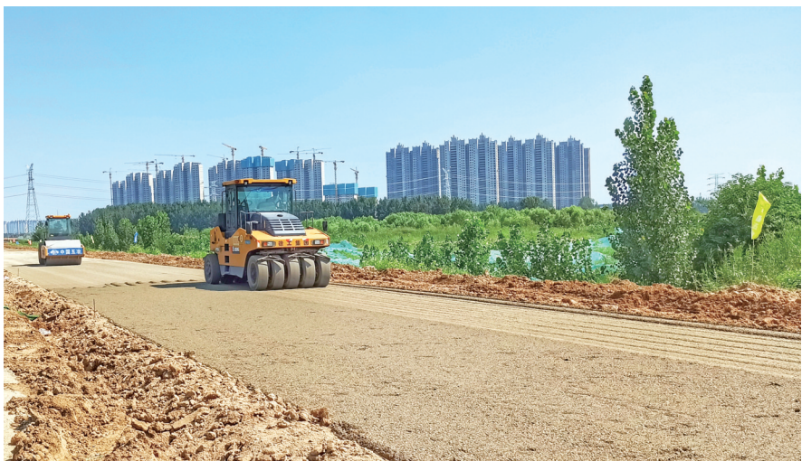
梁济运河西岸道路及景观工程项目建设加快推进。
