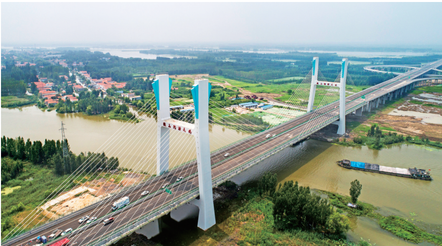
图为枣菏高速微山湖特大桥通车。
