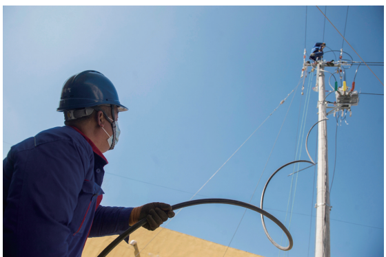
►电力工人迅速抢修保障供电。
