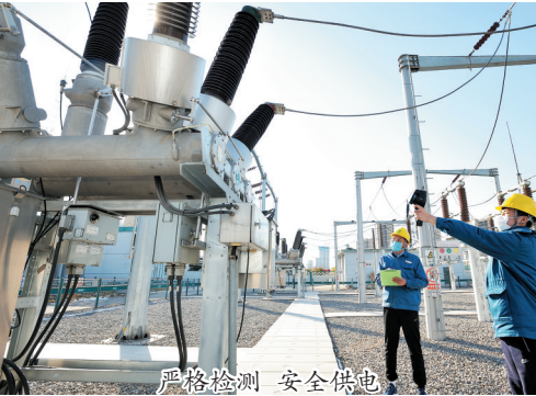
严格检测 安全供电
